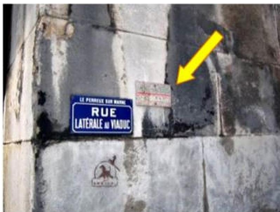
En rive droite, sous le viaduc de Nogent-sur-Marne
