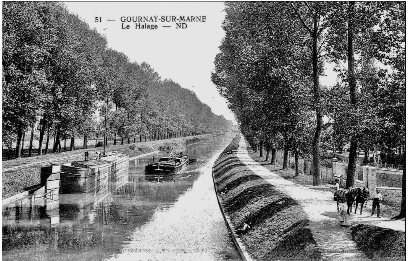
Le canal de Chelles, vu vers l'amont depuis le pont de la rue de Gournay
