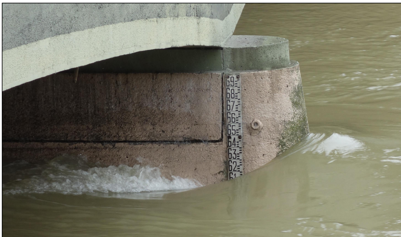
Echelle de crue, amont de la pile gauche du Pont de Gournay, lors du maximum de la crue de 2018 (5.74 m)
