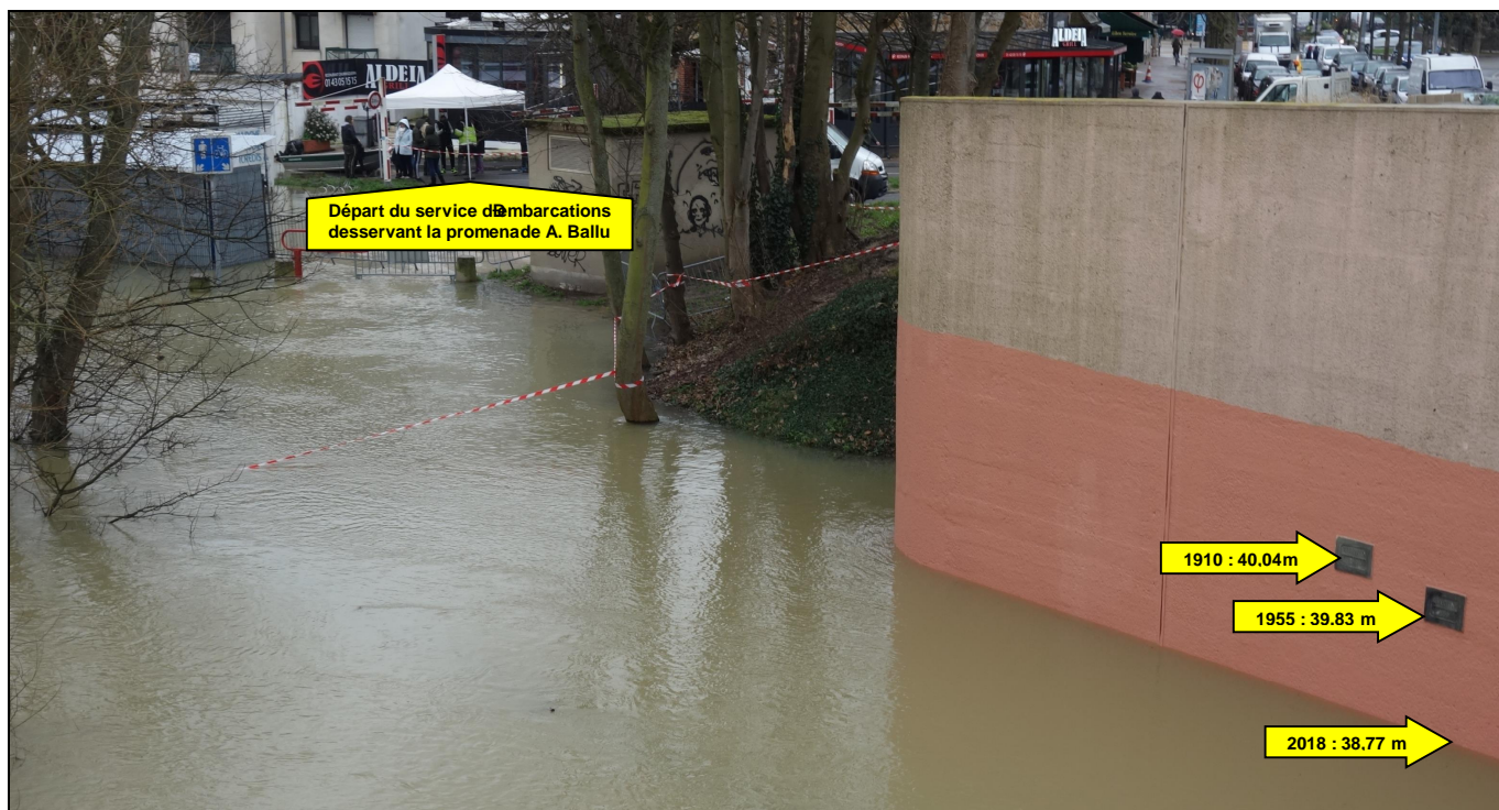
Vue de la pile sud du pont de Gournay, le 3 février 2018, au plus haut de la crue, avec à titre comparatif, les repères des crues de 1955 et de 1910
