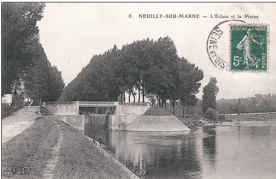
L'écluse de Neuilly, fin du canal de Chelles. La porte aval ouverte permet de percevoir la porte amont. A droite la Marne, dont le niveau à l'étiage peut être jusqu'à 5 mètres sous le niveau du canal (C.P.A Collection Delcampe)
