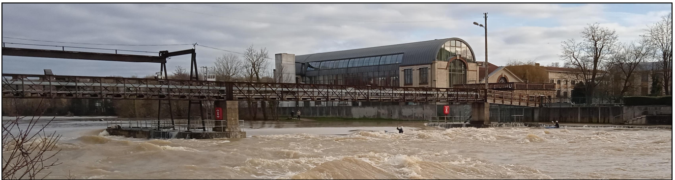
Barrage de Noisiel, crue de février 2021 (clapets et hausses en position effacés)
