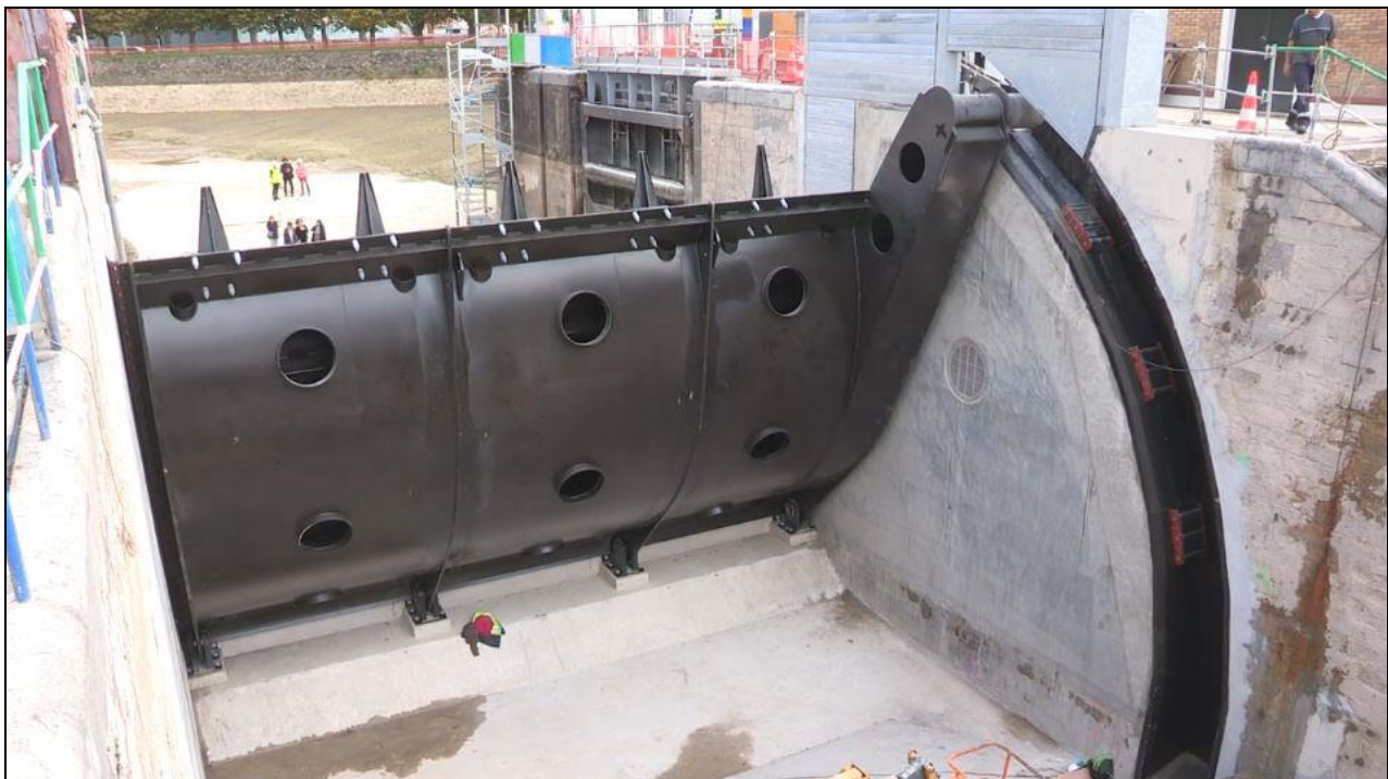
La nouvelle vanne-secteur, en cours de montage en 2017, en position relevée au maximum. Vue de l'intérieur de la clôture, le canal de Saint-Maur asséché pour les travaux au fond de l'ouvrage (photo Département du Val-de-Marne)
