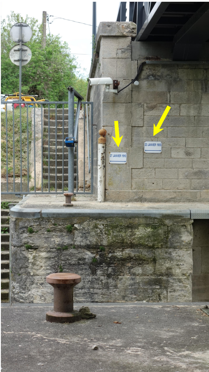
Ecluse de Vaires quai après la porte aval Repères de crue de 1910 et 1955 (plus haut)
