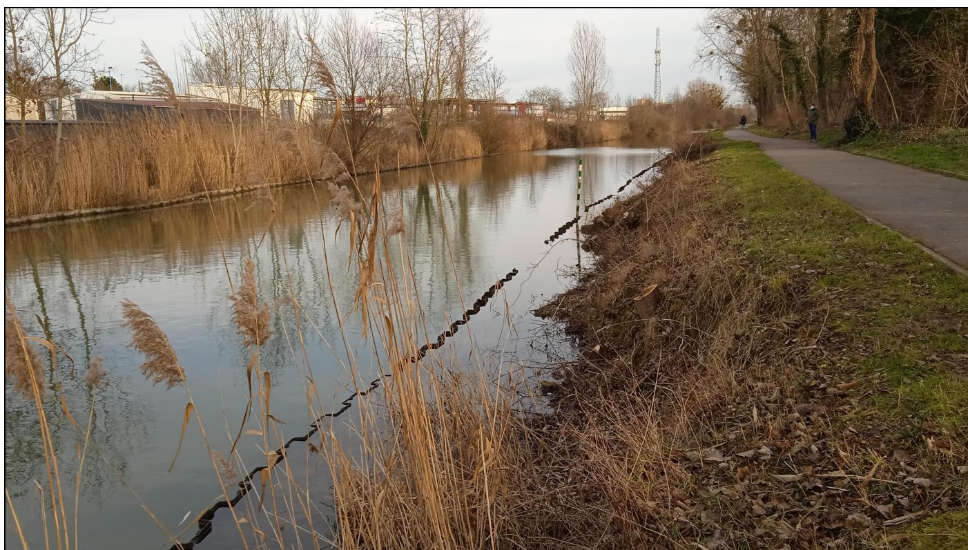
Rive Gauche km 3,725, le même endroit après élagage, laisse apparaître la dégradation sur plus de 50 mètres, janvier 2021
