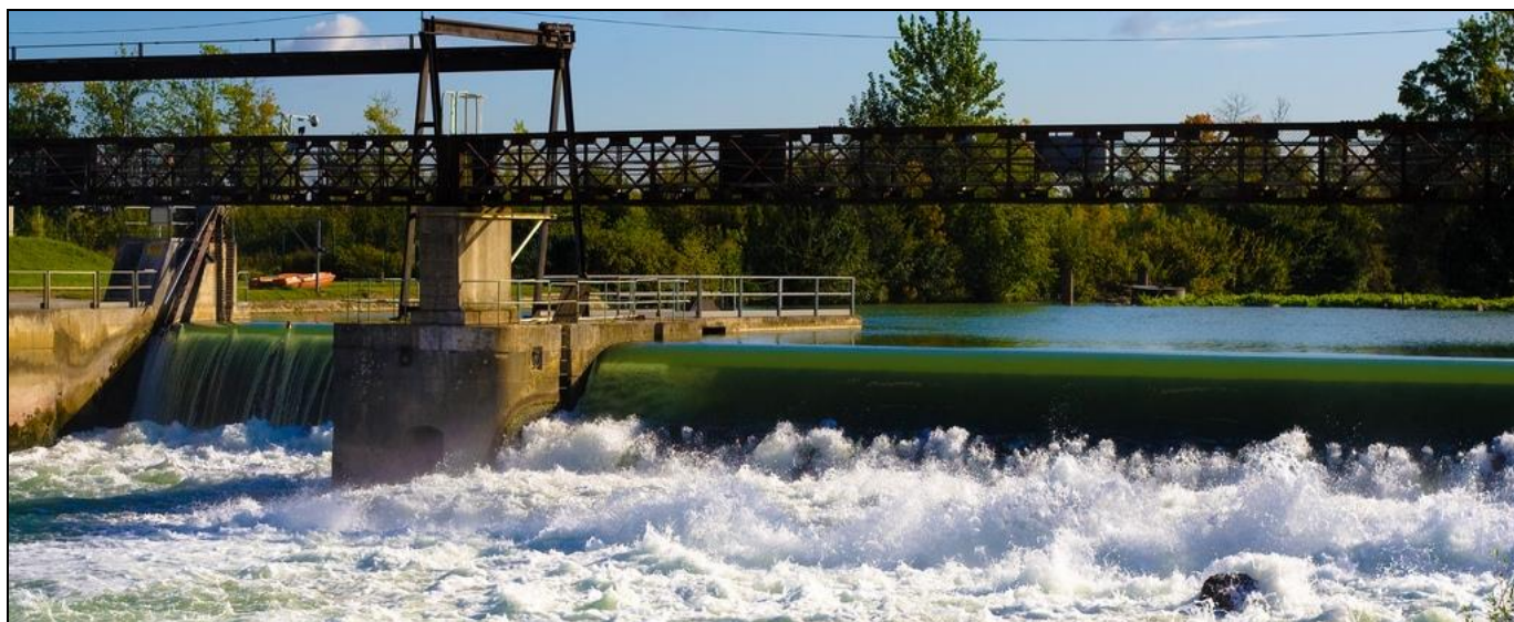
Barrage de Noisiel, en juin 2009, clapets et hausses mobiles en position haute (Goliom Wikimedia Creative Commons)
