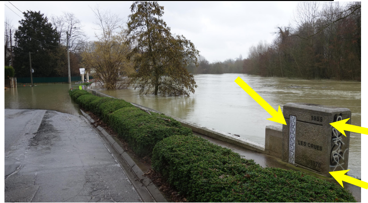
Chelles, quai des Mariniers, échelle de crues Repère de 1955 et 1970, photo prise au max. de la crue de 2018
