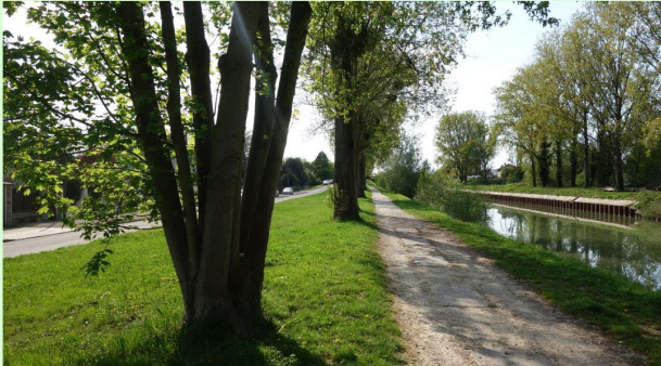
R6 km 4,440, à l'angle de la rue des Canotiers, vue sur RD rénovée, l'état idéal ?
