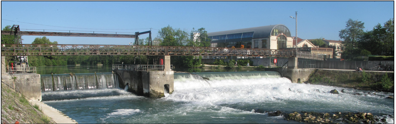
Barrage de Noisiel, en été (clapets et hausses en position haute)
