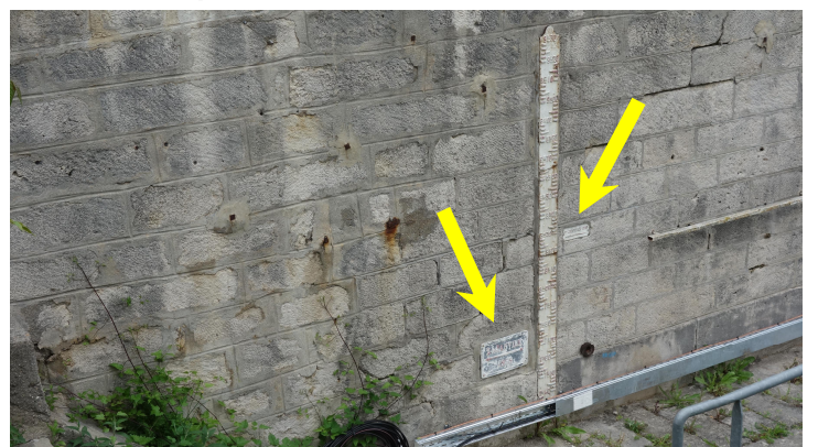
Ecluse de Neuilly, échelle de crue et plaques repères 1910 et 1955
