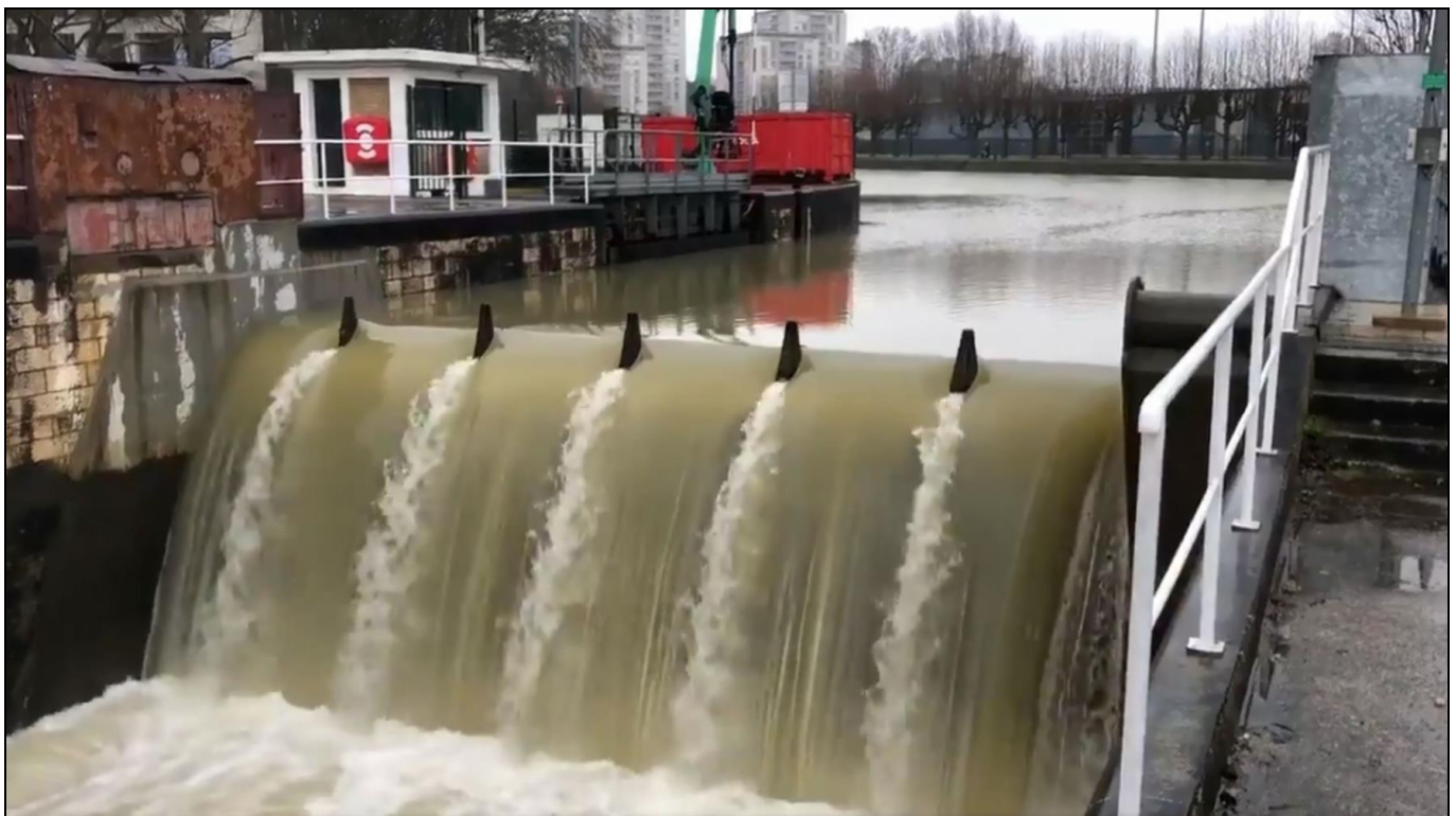
La première utilisation de la vanne-secteur en mode « dérivation de crue » le 6 février 2021 (Twitter C. Favier)
