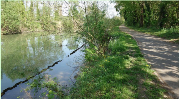
R6 km 3,725, palplanches noyées et rive creusée, vue vers l'amont, mai 2018
