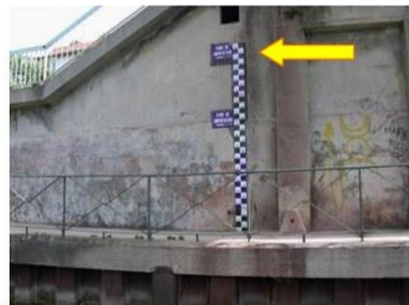
En rive droite, passerelle de la Pie, à Créteil
