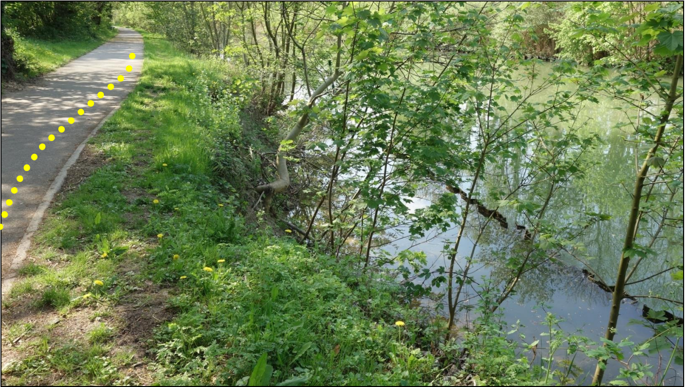
Rive Gauche km 3,725 vue vers l'aval, la Voie Verte créée en 2010 évite soigneusement la dégradation qui aurait gagné à être comblée à l'occasion de ces gros travaux !
