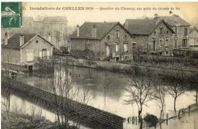
Inondations de 1910 à Chelles, quartier du Chesnay (SAGE / Les Abbesses de Gagny-Chelles)
