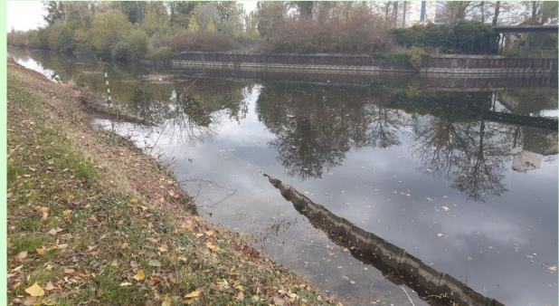
R6 km 3,725, palplanches effondrées et noyées face à l'entrée du quai Calcia
