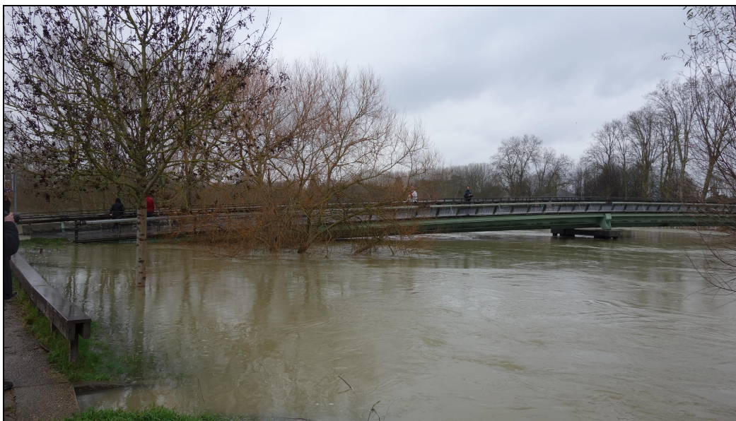
Au maximum de la crue, la passerelle est à la limite de la submersion...
