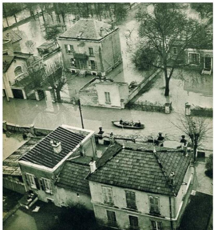
Rupture des protections locales à Saint-Maur en janvier 1955 (SAGE)
