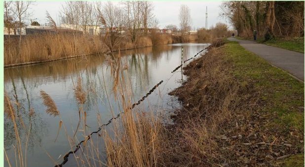
R6 km 3,725, le même endroit après élagage, janv. 2021
