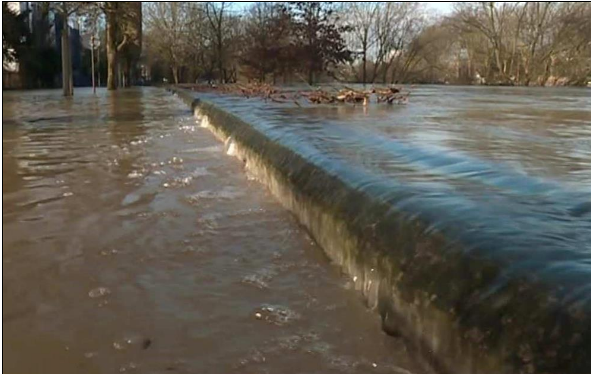
Il s'en est fallu de quelques décimètres ! Submersion du muret anti-crués de la promenade A. Ballu à Gournay, 2 février 2018 (photo le Parisien)
